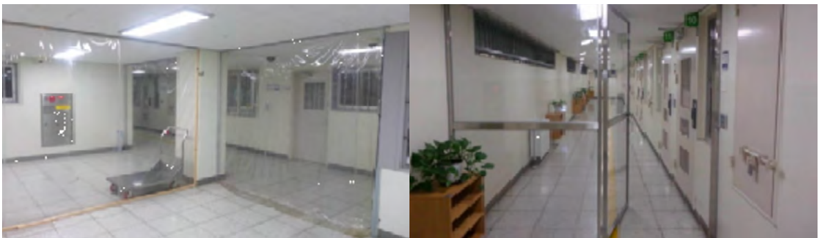
〈그림 5〉 수용동 복도 차단막(비닐 차단막, 아크릴 차단문) 설치
